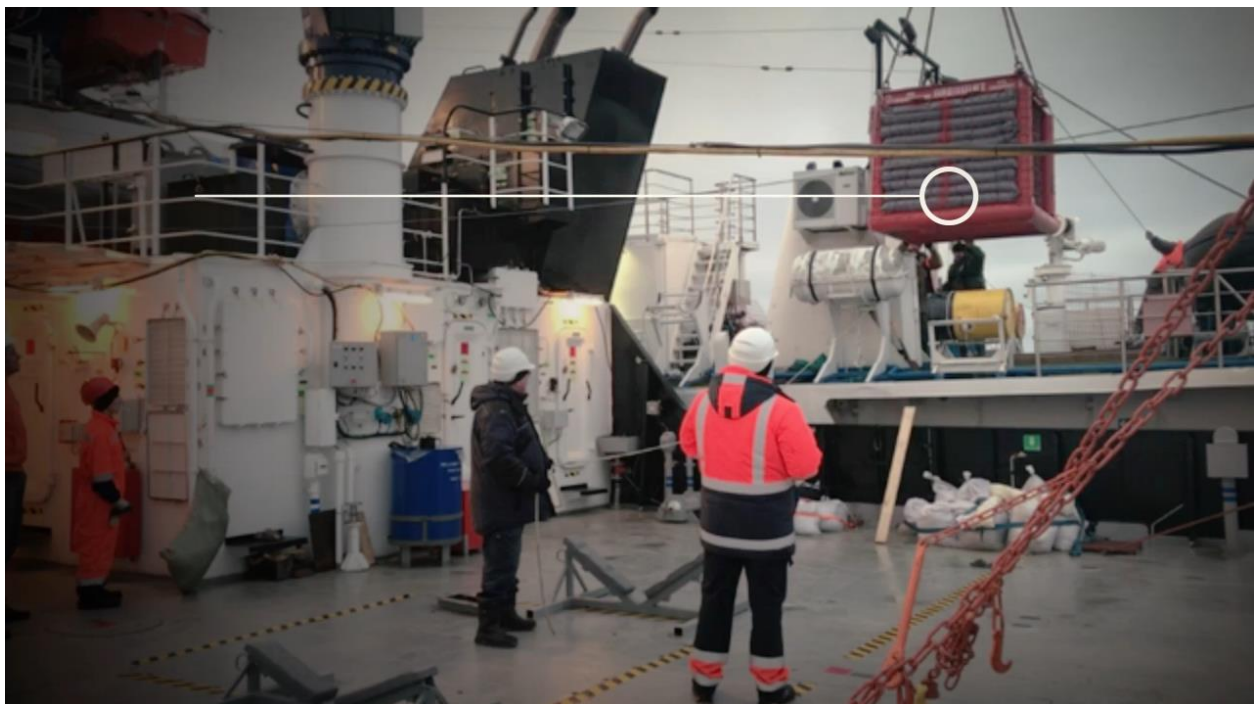
Рисунок 10 – фотография подъёма устройства «Аквацит» краном для установки на месте подрыва
